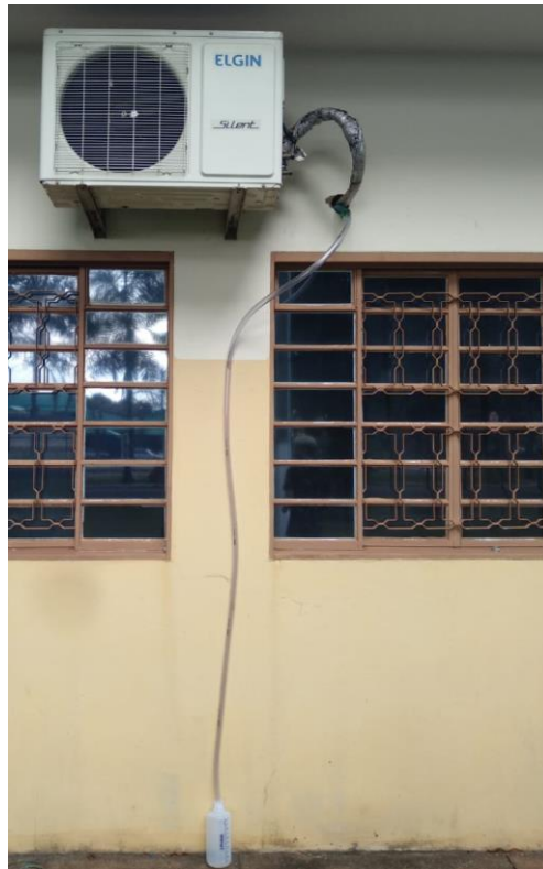
Figura 6: Sistema de captação provisória
