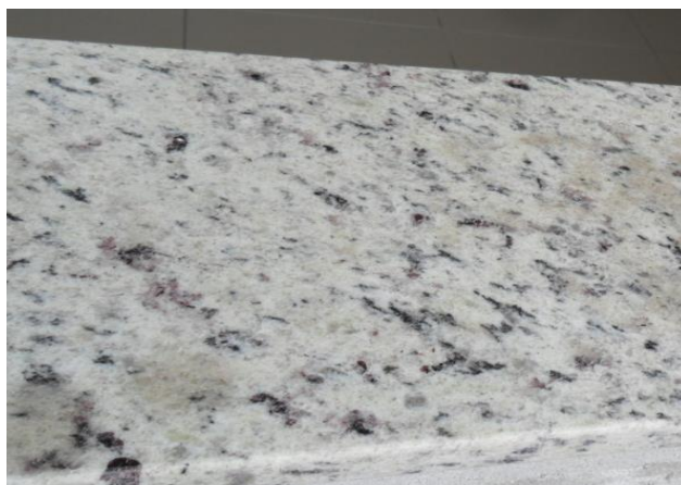
Figura 4 - Granito Branco Dallas em janela.
