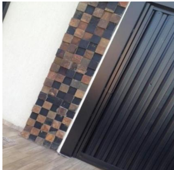
Figura 7 - Revestimento de parede com quartzitos. Fonte: Autor (2019).
