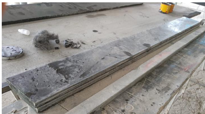
Figura 31 - Colagem realizada em peitoril.
