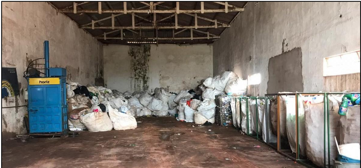
Figura 11. Galpão de armazenamento dos resíduos na COOP-RECICLA
