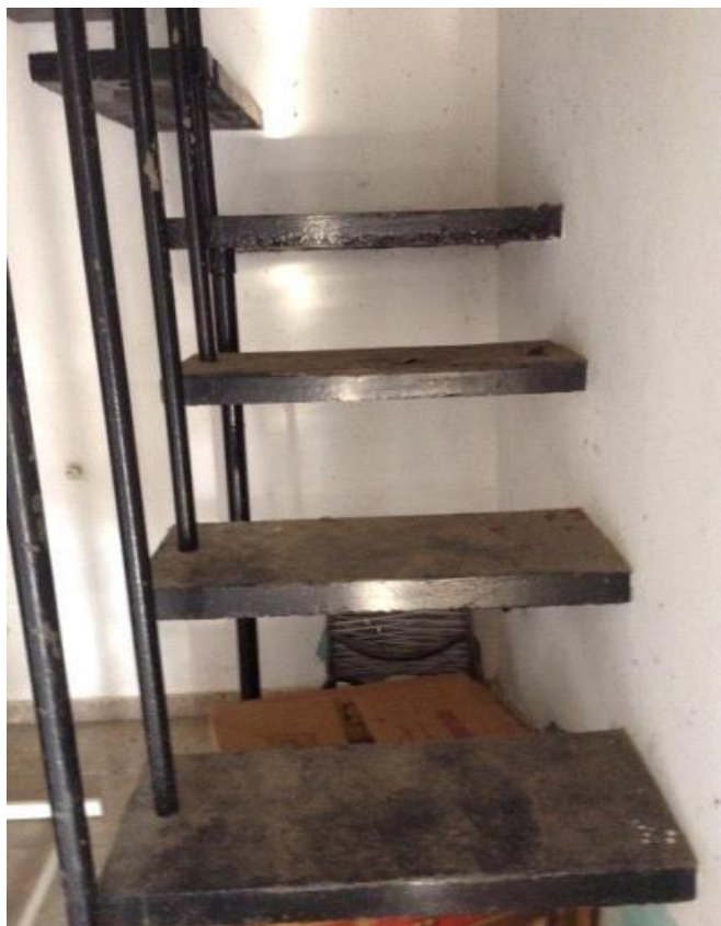
(Imagem 10: Escada de acesso à sala de projeção. Foto: Abel de Castro 2017)
