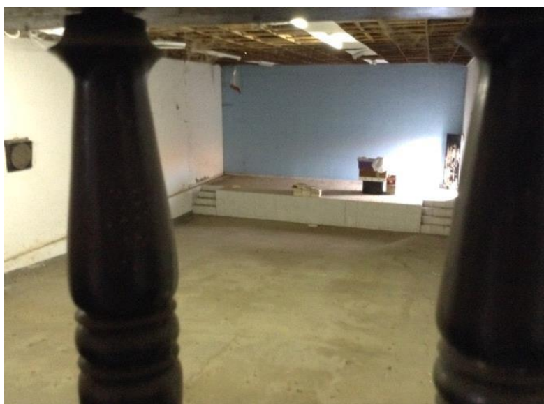
(Imagem 11: Balcão que separava a sala de projeções do salão principal. Foto: Abel de Castro, 2017)
