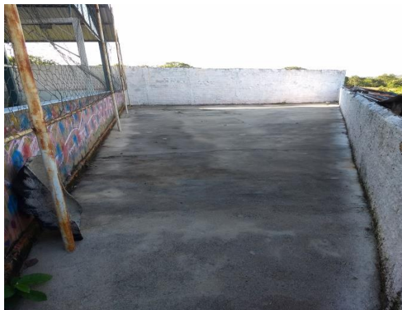
Figura 7 - Colégio Pitágoras: Espaço atrás da quadra de esportes que pode ser utilizado para colocação de espaços verdes compactos.
