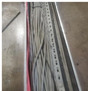
b) Cabo de rede colocado separado.
