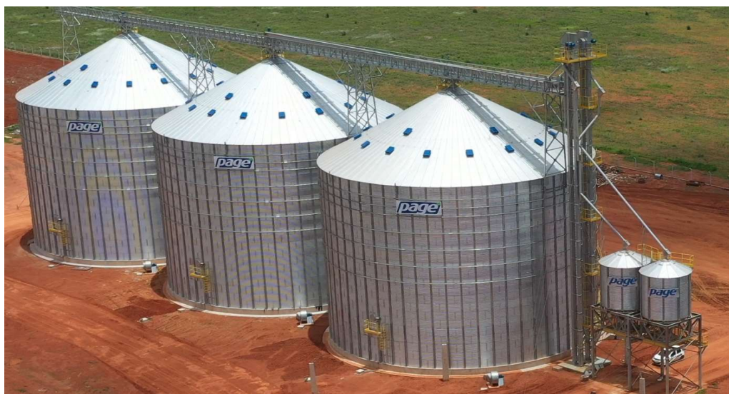
Figura 3 - Silo vertical de fundo plano para armazenamento de grãos a granel
