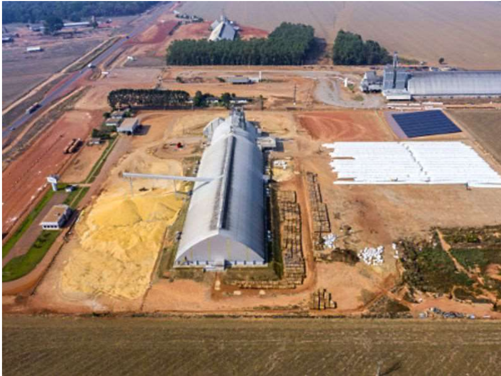
Figura 4 - Silo Horizontal – graneleiro utilizado para armazenamento de grãos a granel
