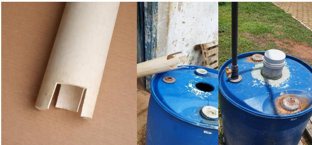
Figura 9 - Apresentação do sistema de alimentação instalado no biodigestor
