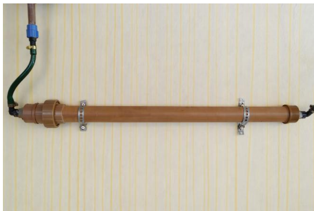
Figura 12 - Sistema de filtros para de gás sulfídrico
