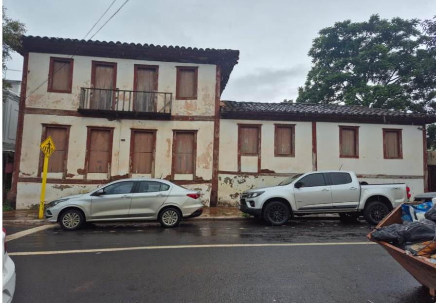
Figura 5 – Situação atual do Casarão Fonte: Próprio Autor
