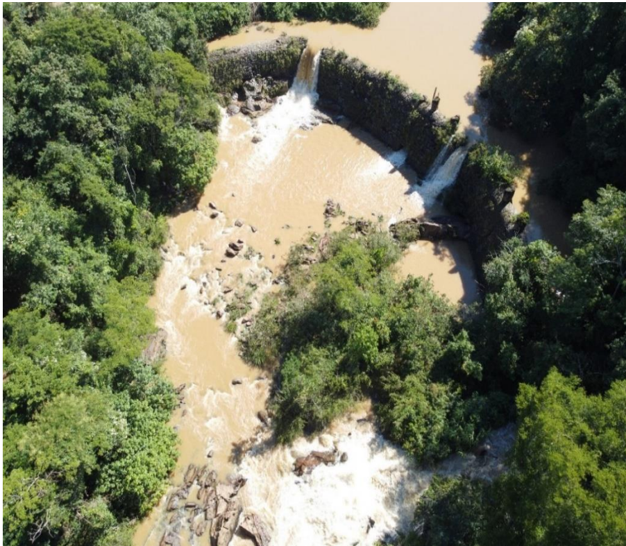
Figura 15. Vista da Usina Hidrelétrica do Rio do Braço - Imagem de Drone (2023). Crédito: Jair de Souza Júnior
