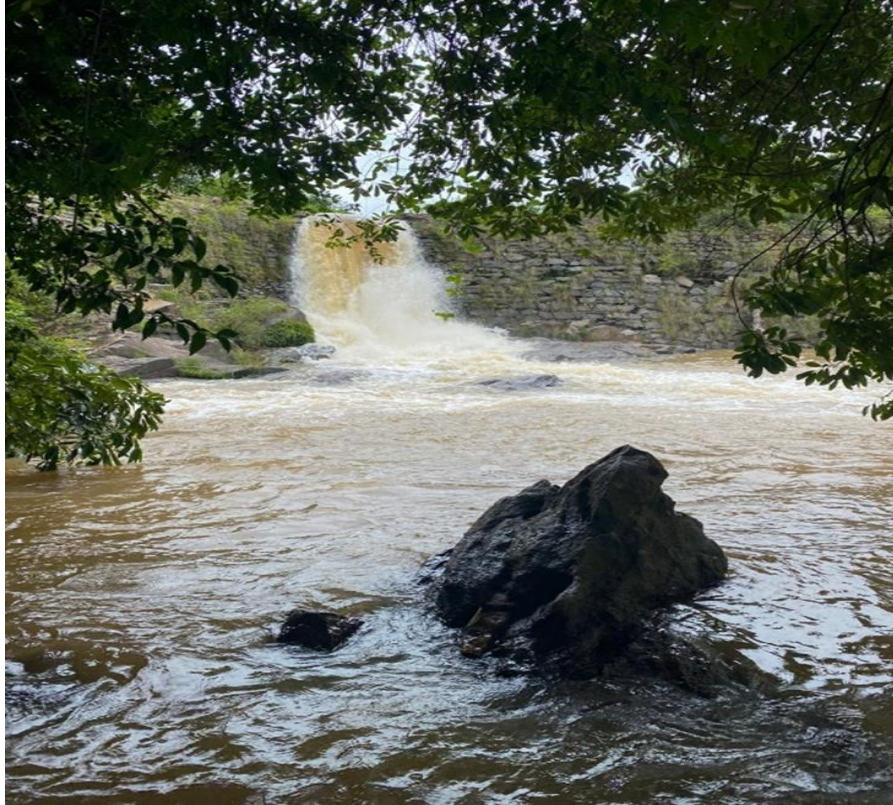
Figura 14. Estrutura atual da Usina Hidrelétrica do Rio do Braço (dezembro de 2024).
