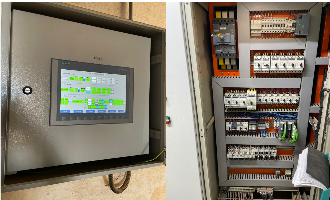
Figura 15 – Painel de controle do sistema de secagem de grãos de soja (a). Fonte: Autor (2026).
