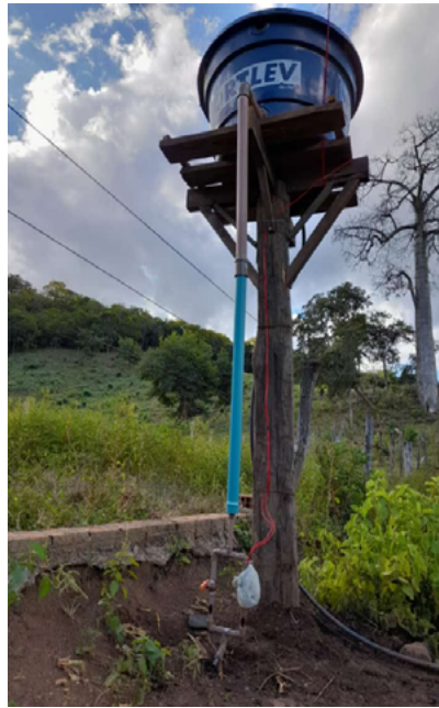
Figura 5 - Instalação de sistema para irrigação
