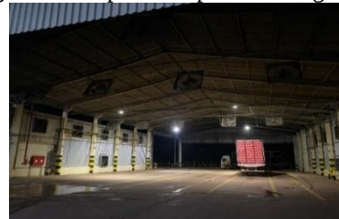
Figura 1- Galpão de espera do frango vivo
