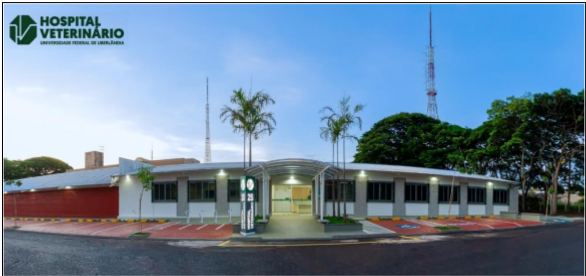
Figura 1- Fachada Hospital Veterinário da Universidade Federal de Uberlândia. Fonte: Arquivo de
