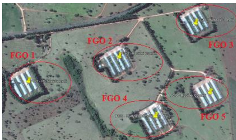
Figura 4. Vista aérea dos Aviários (FGO) localizados na zona rural em Rio Verde-GO (Google Earth, 2018)
