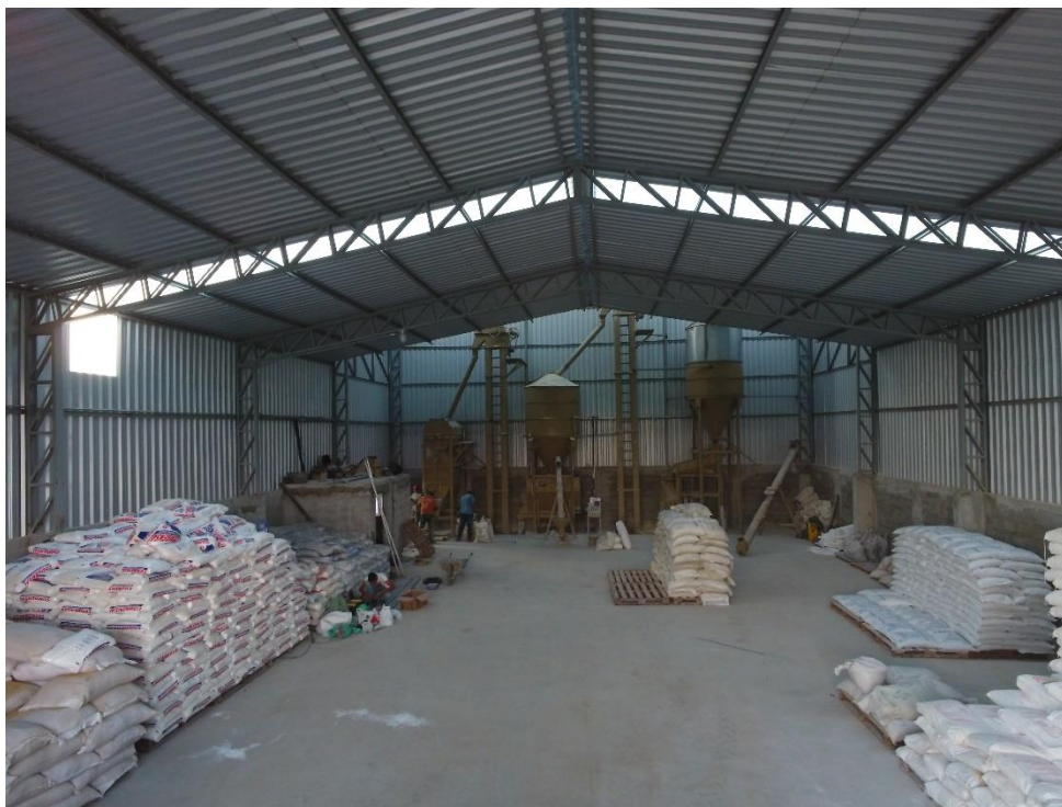
Figura 3: Interior da fábrica de ração, com sacarias estocadas de forma adequada, assegurando organização, conservação dos insumos e qualidade na alimentação dos animais. Fonte: Acervo de fotos – Agropecuária Pontal, 2025.
