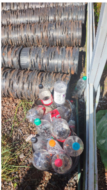
1. Separação de garrafas PET para o sistema de drenagem
