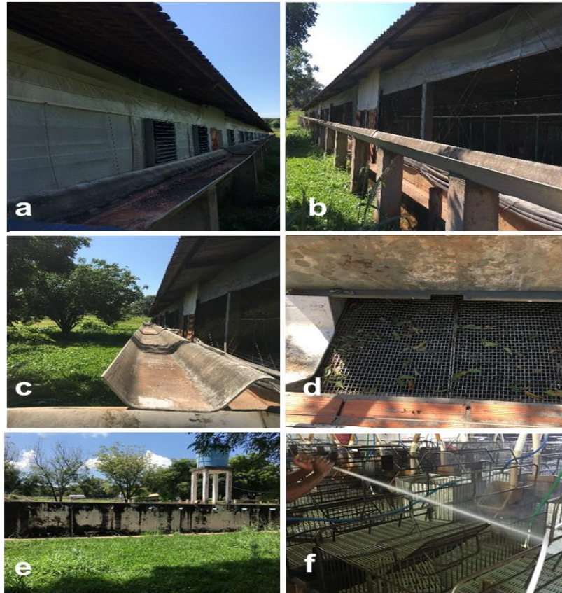
Figura 5. Estrutura e etapas do sistema de coleta de água pluvial constituídas por a) Telhado da maternidade, b) Telhado da creche; c) Escoamento da água por telhas de amianto; d) Caixa de cimento com tela filtrante; e) Cisterna de armazenamento e caixa elevatória e f) Higienização das instalações.
