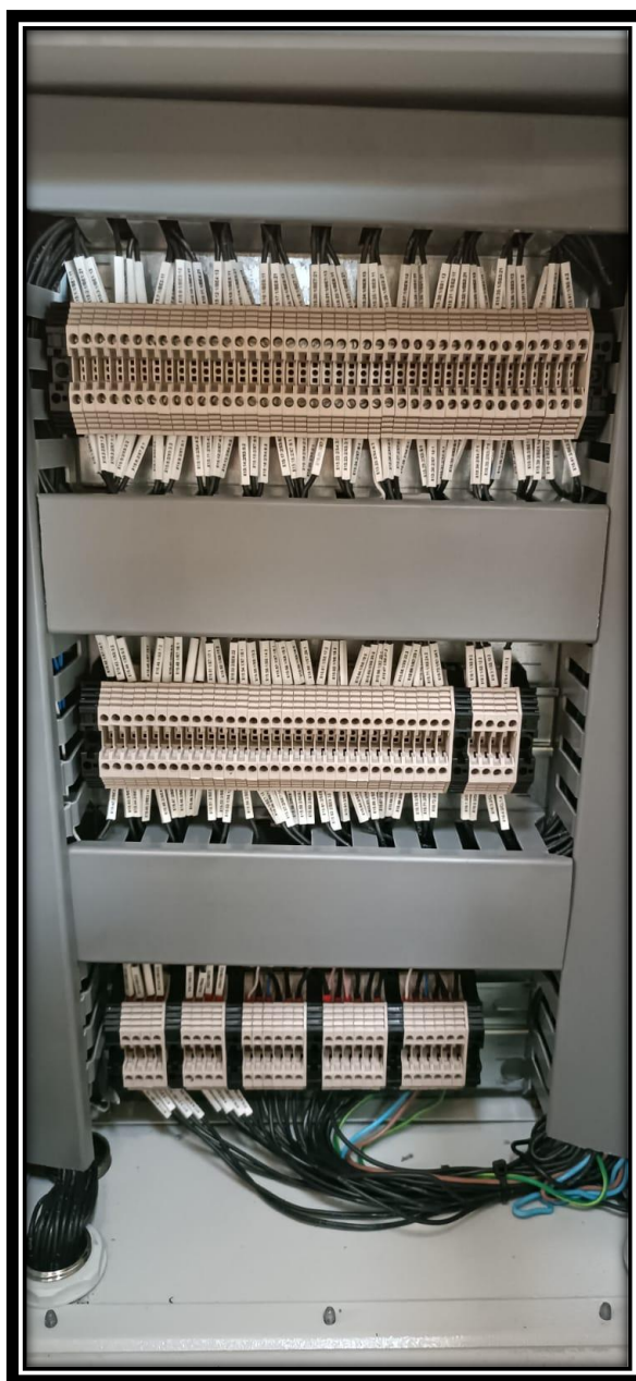
Figura 45 - Pannel de passagem de cabos organizado
