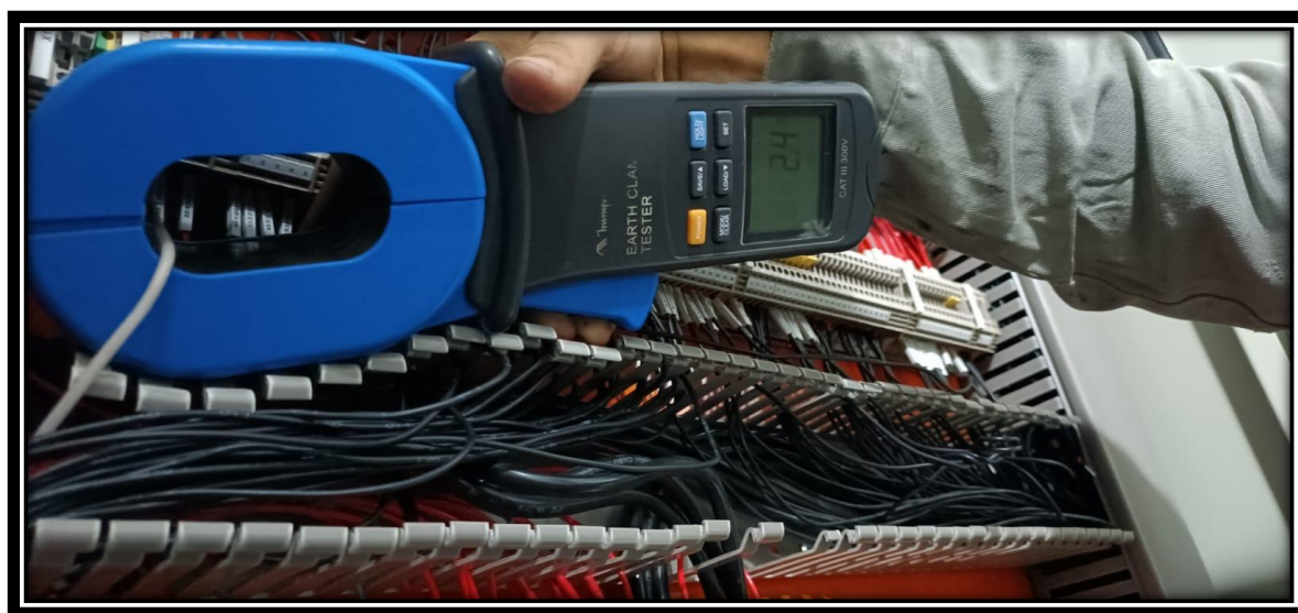
Figura 47 - Teste de aferição de energização do painel – B
