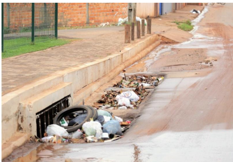
Figura 4. Bueiro entupido de lixo impedindo a infiltração da água.
