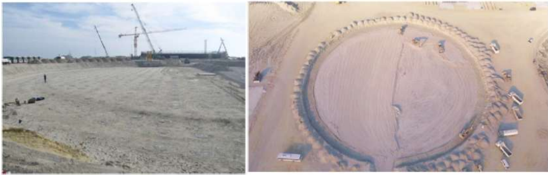
Figura 8. Vista geral da construção das inclusões e da PTC. Fonte: BERNUY et al. , (2018).
