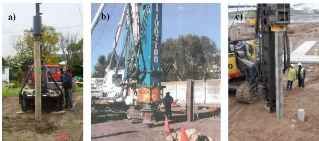
Figura 3. Inclusões pré-fabricadas. a) de madeira b) metálica c) de concreto. Fonte: Malcom, (2013).
