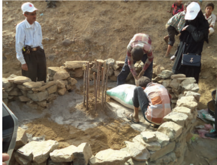
Figura 6 - Processo de construção da horta
