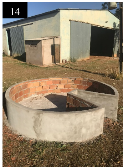
Figura 14 - Construção da horta: Camada 01
