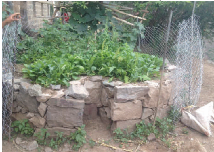
Figura 9 - Processo de construção da horta
