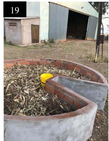
Figura 19 - Construção da horta: Camada 04
