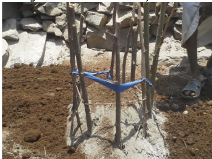
Figura 3 - Processo de construção da horta
