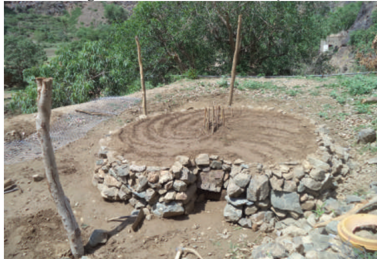
Figura 8 - Processo de construção da horta
