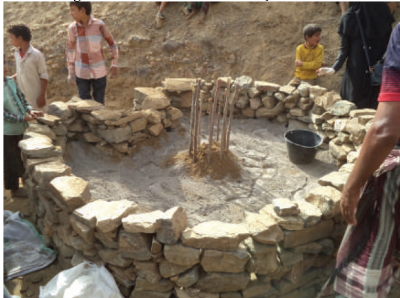
Figura 5 - Processo de construção da horta
