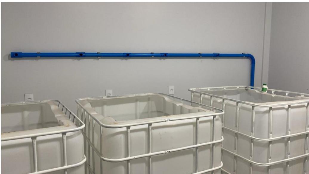
**Figura 4.** Estrutura e canalização para a saída de gás. Fonte: Arquivo pessoal (2024).
