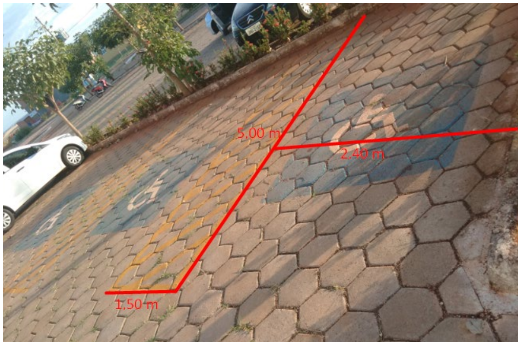
Figura 26 - Estacionamento - Bloco das Engenharias II Fonte: Autora (2019).
