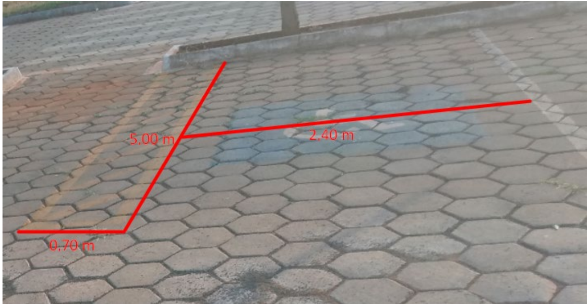
Figura 27 - Estacionamento - Bloco das Engenharias II Fonte: Autora (2019).
