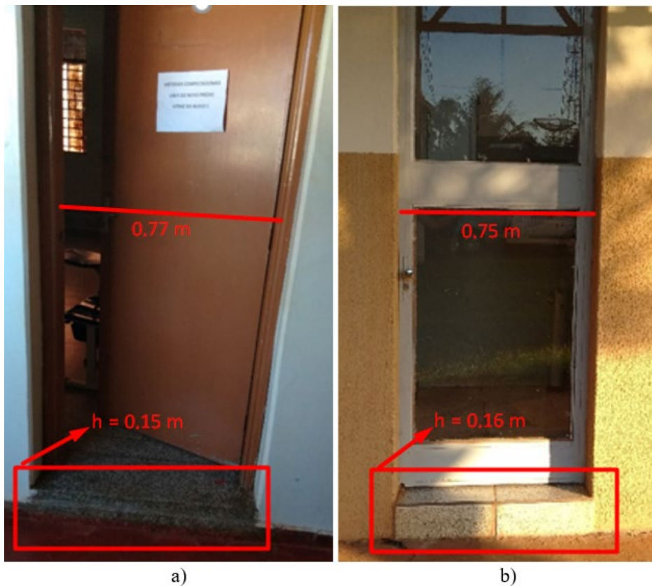
Figura 14 - Portas - a) Pavilhão Pedagógico I; b) LABIM Fonte: Autora (2019).
