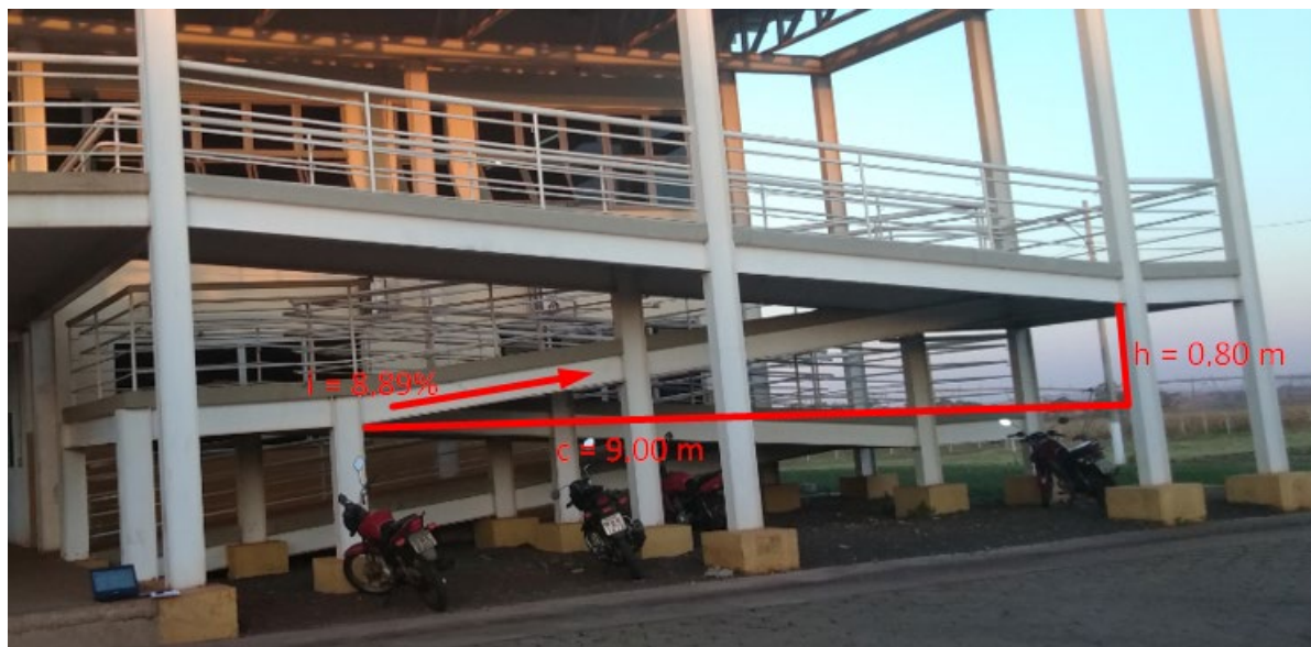
Figura 36 - Rampa - Bloco das Engenharias II (lance 3) Fonte: Autora (2019).
