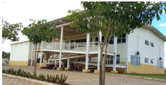
Figura 4 - Bloco das Engenharias Fonte: Autora (2019).
