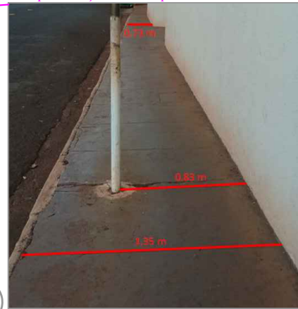
Figura 17 - Calçada - Ginásio Fonte: Autora (2019).
