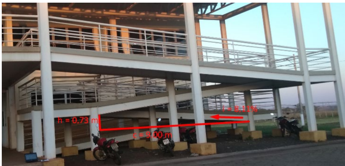
Figura 34 - Rampa - Bloco das Engenharias II (lance 2) Fonte: Autora (2019).
