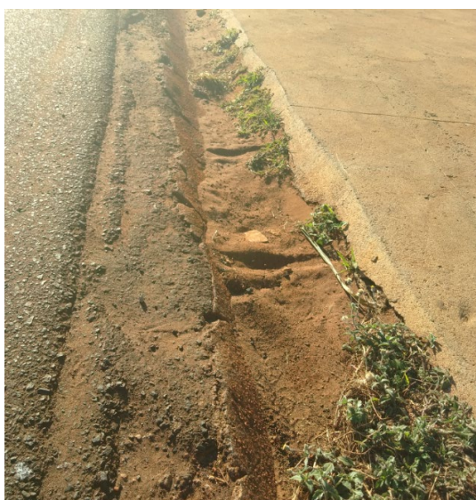
Figura 40 - Valeta entre rua e calçada de acesso à biblioteca Fonte: Autora (2019).
