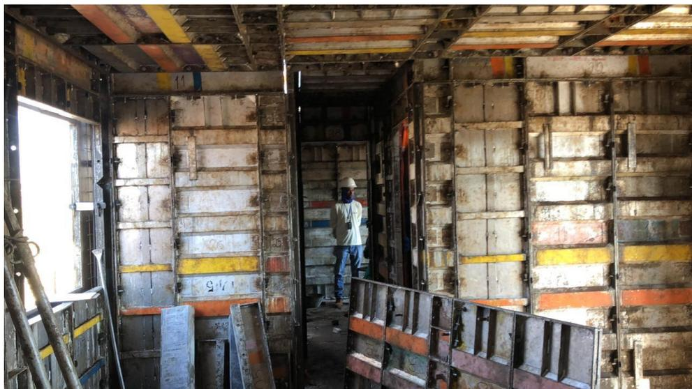
**Figura 28** - Montagem das formas metálicas
