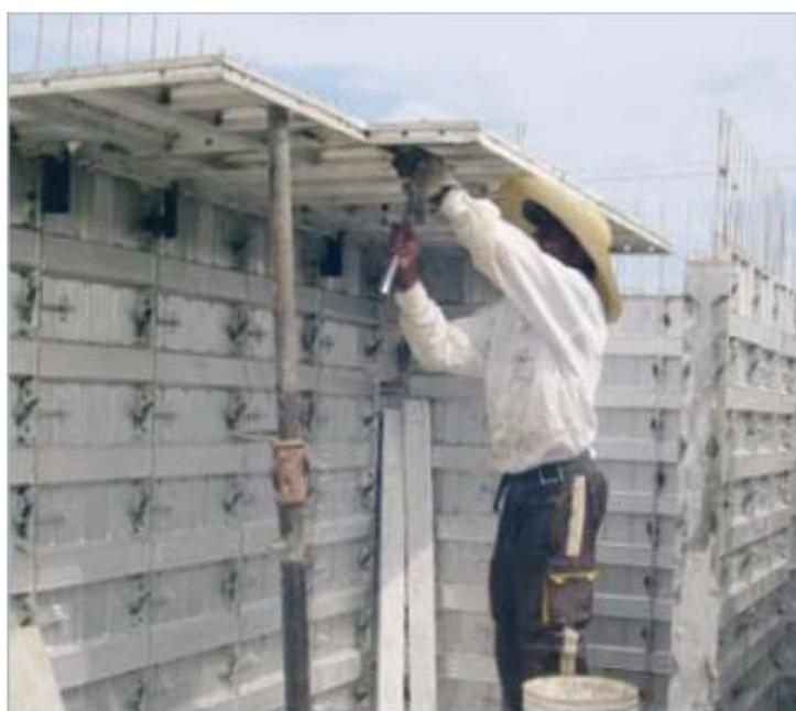
**Figura 21** – Montagem das formas da laje com auxílio de escoras.
