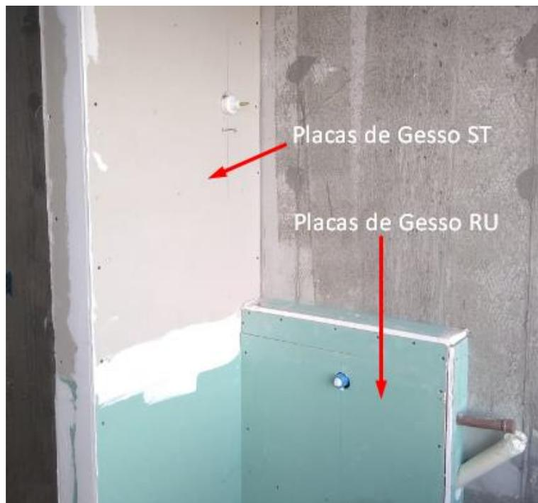
**Figura 31-** Embutimento das instalações hidráulicas da área de serviço.
