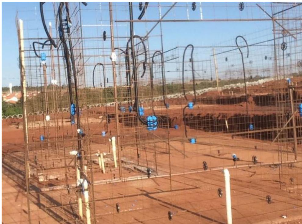
**Figura 36** –Instalações fixadas nas telas soldadas.
