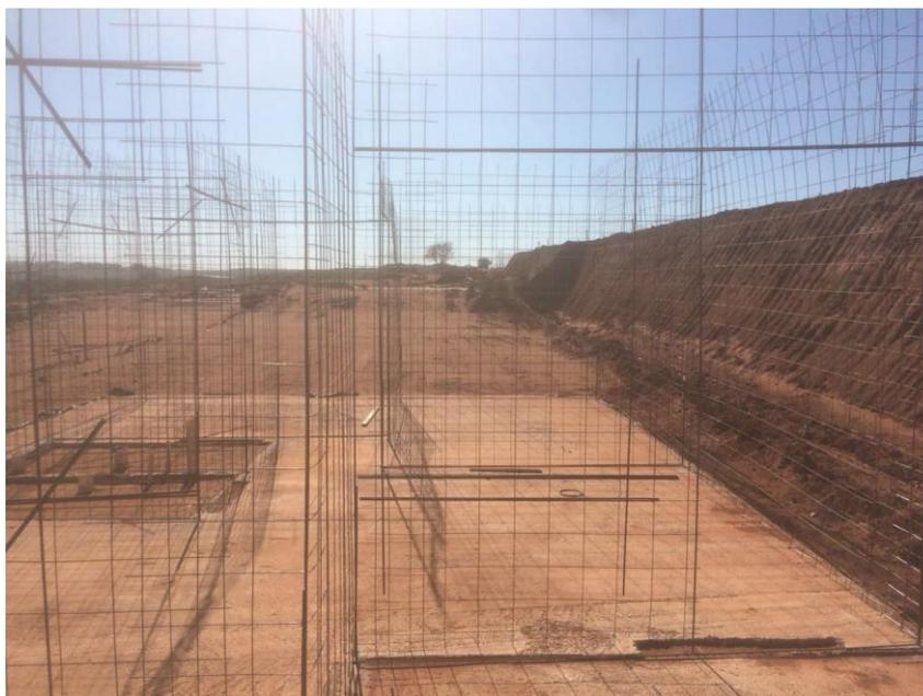
**Figura 14** – Utilização da tela soldada para estruturação das paredes e barras de aço para reforço das aberturas.
