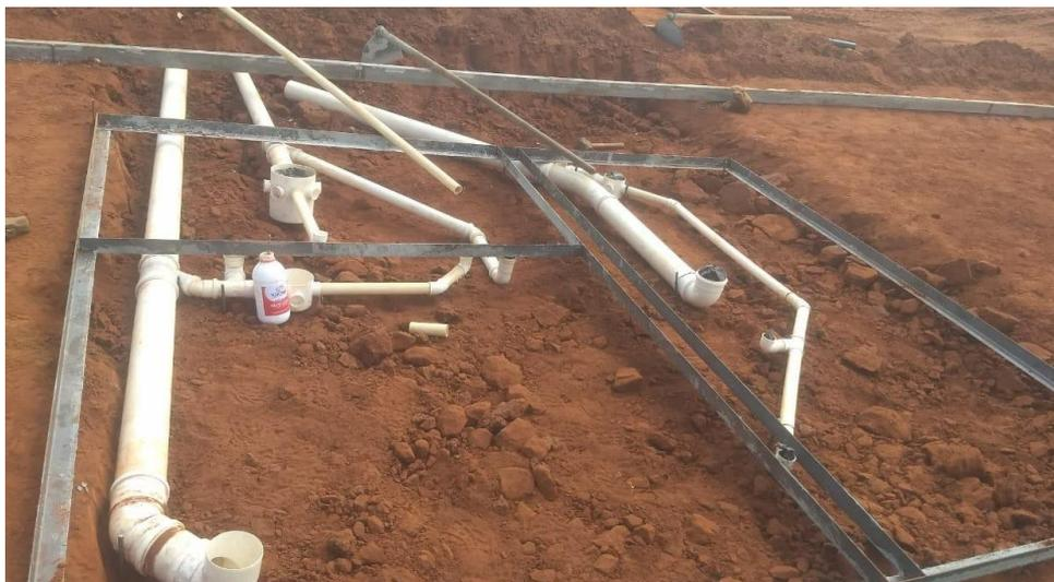
**Figura 32** – Passagem das tubulações de esgoto embutidas no radier .
