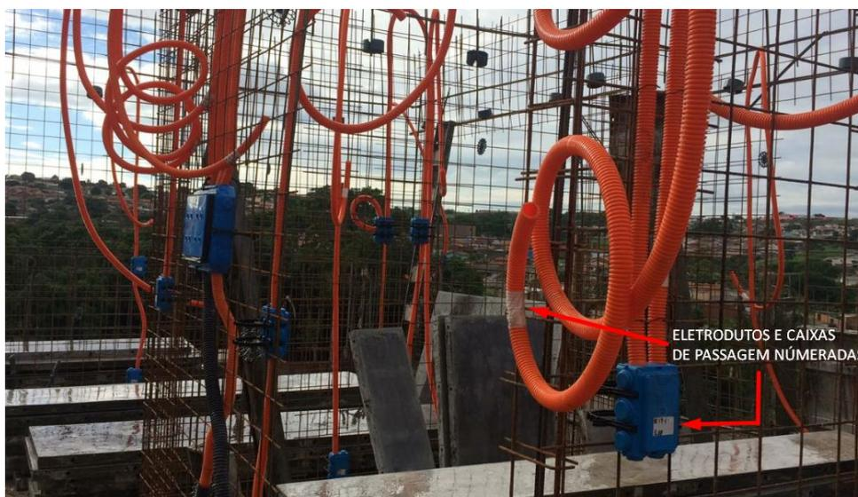
**Figura 27** – Instalações elétricas numeradas e fixadas nas telas.
