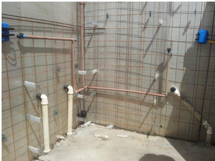
**Figura 19** – Instalações hidráulicas e elétricas fixadas nas armações.
