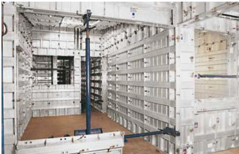
**Figura 11- Formas metálicas em alumínio.**
