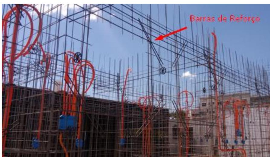
**Figura 17** – Montagem das telas soldadas e barras de reforço.
