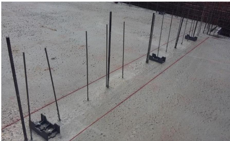
**Figura 16** – Marcação para posicionamento das telas soldadas e formas.
