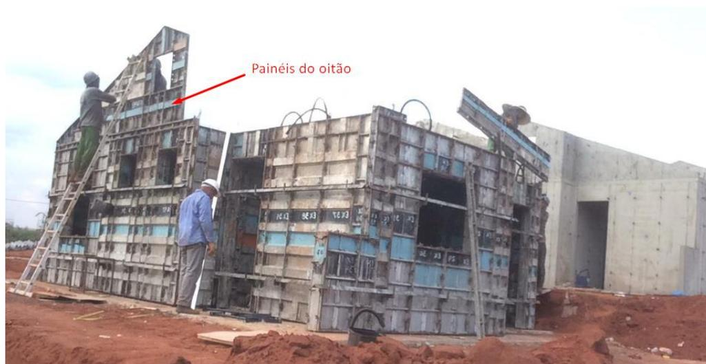
**Figura 34** – Montagem dos painéis metálicos do sistema de formas.
