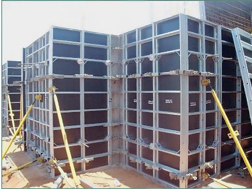
**Figura 12** - Formas metálicas com compensado.
