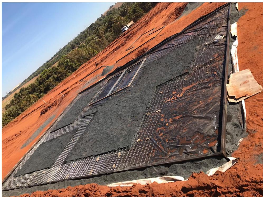
**Figura 33** – Radier antes da concretagem.
