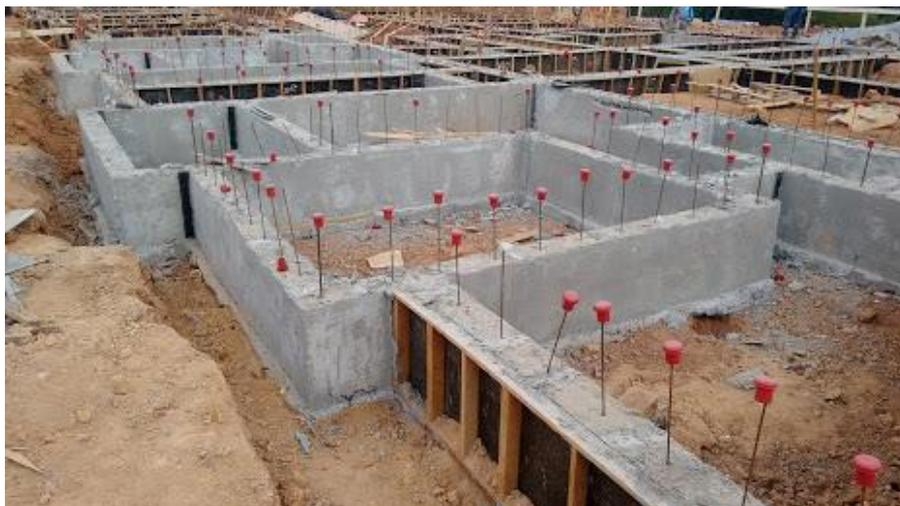
**Figura 26** –Viga baldrame apoiada em estacas hélices contínua.
