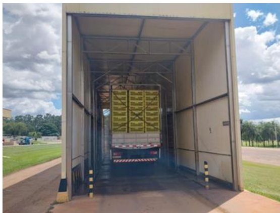
Figura 5: Arco de Desinfecção de Caminhões e Gaiolas da SSA, 2025.
