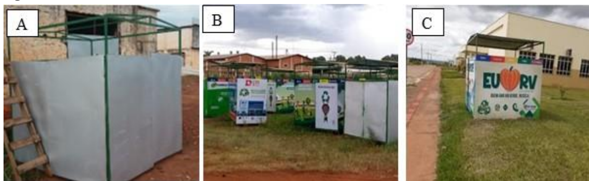
Figura 4. A, B e C. PEVs fabricado em estrutura metálica.
