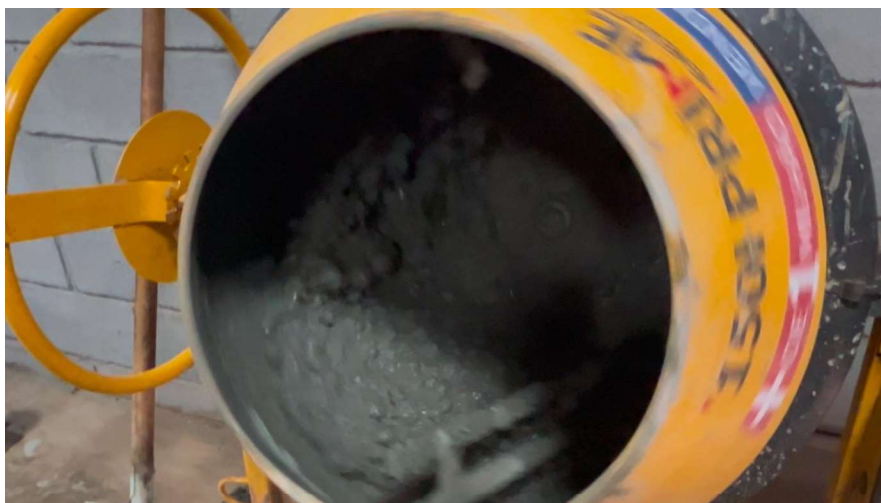
Figura 9 - Mistura de concreto.
