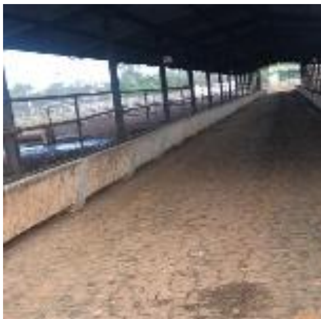
Figura 3 - Vista interna do confinamento de concreto
