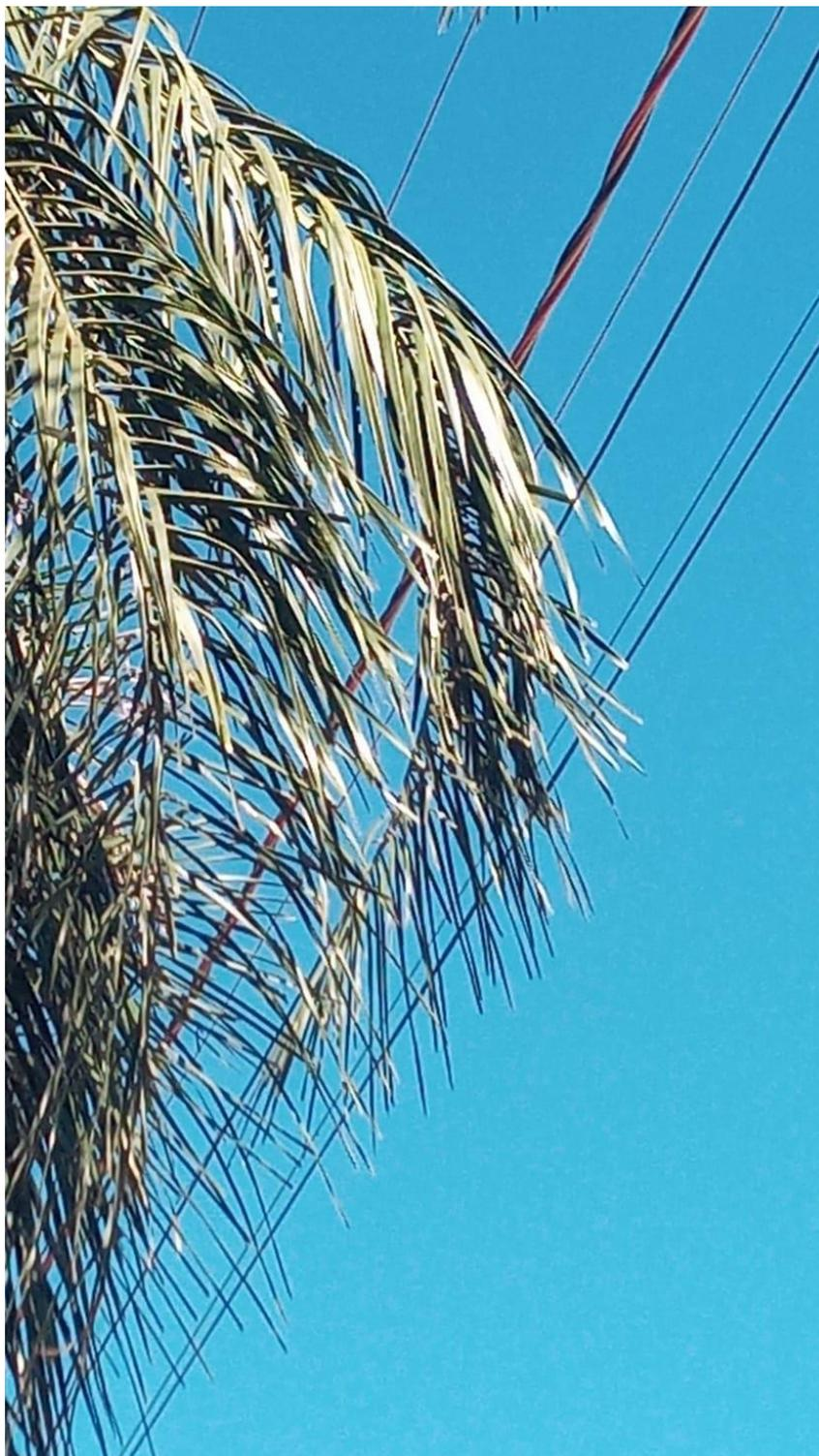
**Figura 14:** Galhos de árvore em contato com a rede elétrica, a poda é realizada pela concessionária responsável, atual Equatorial. Fonte: Autor, 2024
