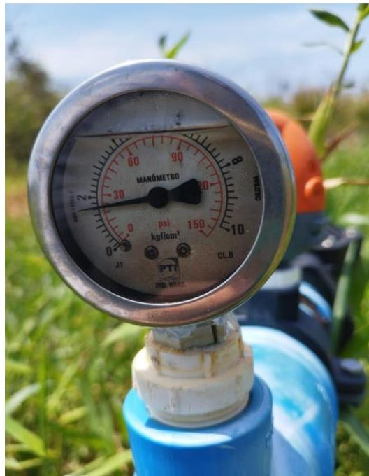
Figura 3 - Aferição de pressão de serviço com manômetro de glicerina no cavalete de irrigação de 1,5 bar
