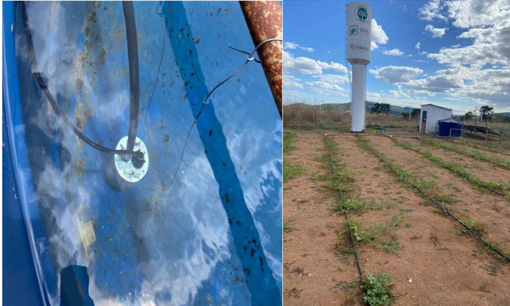
**Figura 2** – Fotos da motobomba submersa (foto esquerda) instalada no reservatório de água azul e projeto instalado a campo com sistema de gotejamento acoplado a motobomba solar (foto esquerda)
