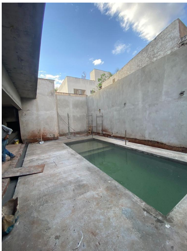
Figura 29 - Teste de carga sistema de Argamassa Polimérica.
