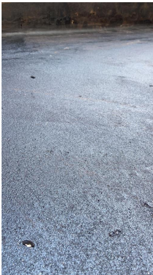
Figura 8 - Superfície após a secagem do primer aplicado e detalhe do canto arredondado.
