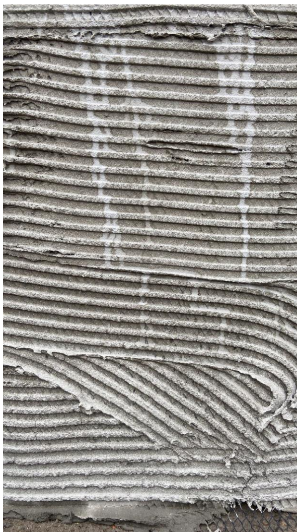
Figura 12- Argamassa ACIII aplicada sob a manta com tela estruturante. Fonte: Autor, 2022.
