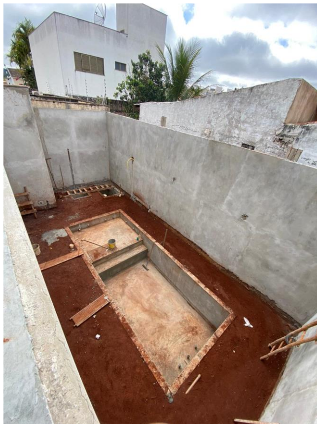
Figura 16- Piscina com superfície regularizada. Fonte: Autor, 2023.
