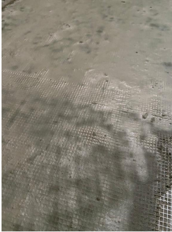
Figura 26 - Aplicação da quinta demão, produto em estado fresco. Fonte: Autor, 2023.
