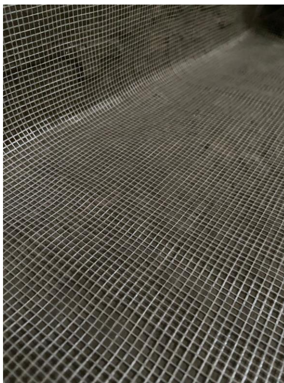
Figura 19- Inserção de tela estruturante e detalhe cantos arredondados. Fonte: Autor, 2023.
