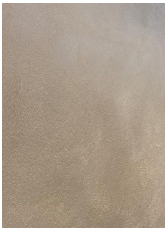
Figura 15- Argamassa desempenada em superfície vertical. Fonte: Autor, 2022.
