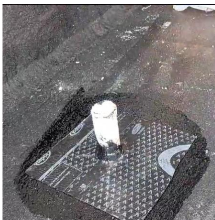
Figura 11- Detalhe de reforço dos drenos de fundo e cantos da piscina arredondados. Fonte: Autor, 2022.
