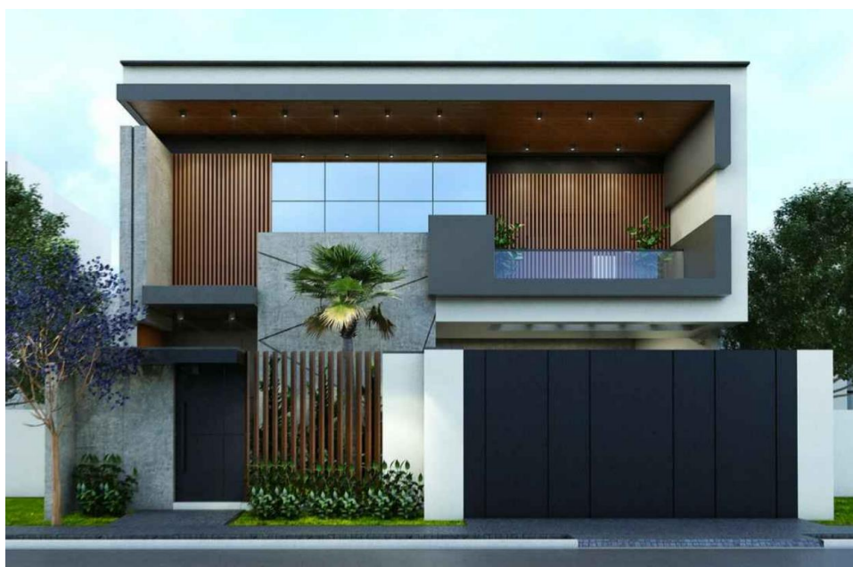
Figura 6- Obra estudo de caso 2. Fonte: Arquiteto Jackson Schmidt.
