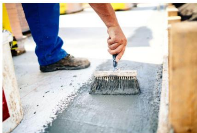
Figura 2- Aplicação da argamassa polimérica. Fonte: (FIBERSALS, 2020)
