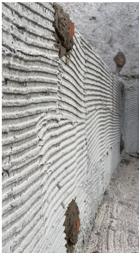
Figura 13- Taliscamento para proteção mecânica vertical.
