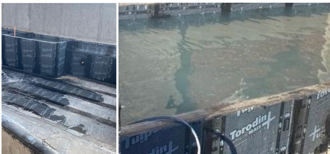
Figura 28 - Teste de carga sistema de Manta Asfáltica. Fonte: Autor, 2022.
