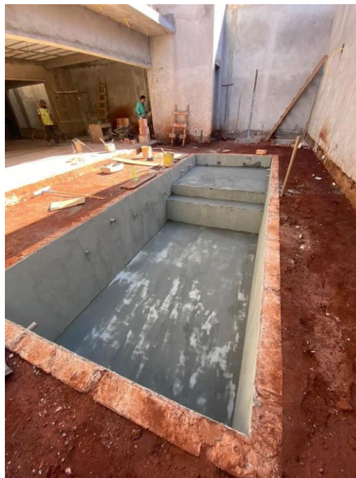
Figura 27 - Resultado da piscina após a quinta demão. Fonte: Autor, 2023.
