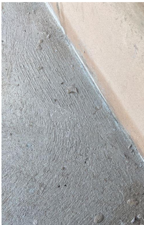
Figura 14- Detalhe quinas em 90° em proteção mecânica Fonte: Autor, 2022.
