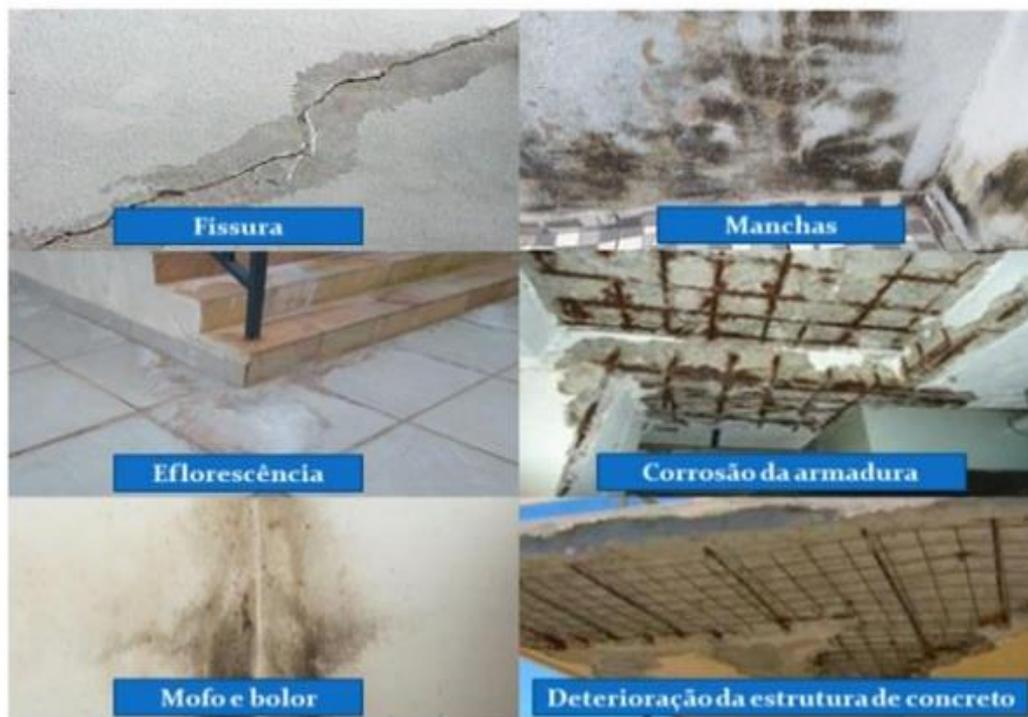
**Figura 2:** Exemplos de patologias que podem ser causadas por umidade.
