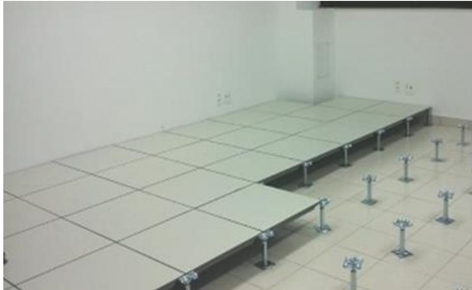
**Figura 19:** Exemplo de plataforma e piso elevado sobre um já existente.
