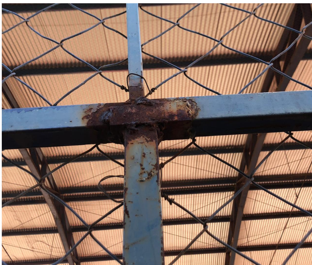
Figura 12 – Limpeza do material oxidado.
