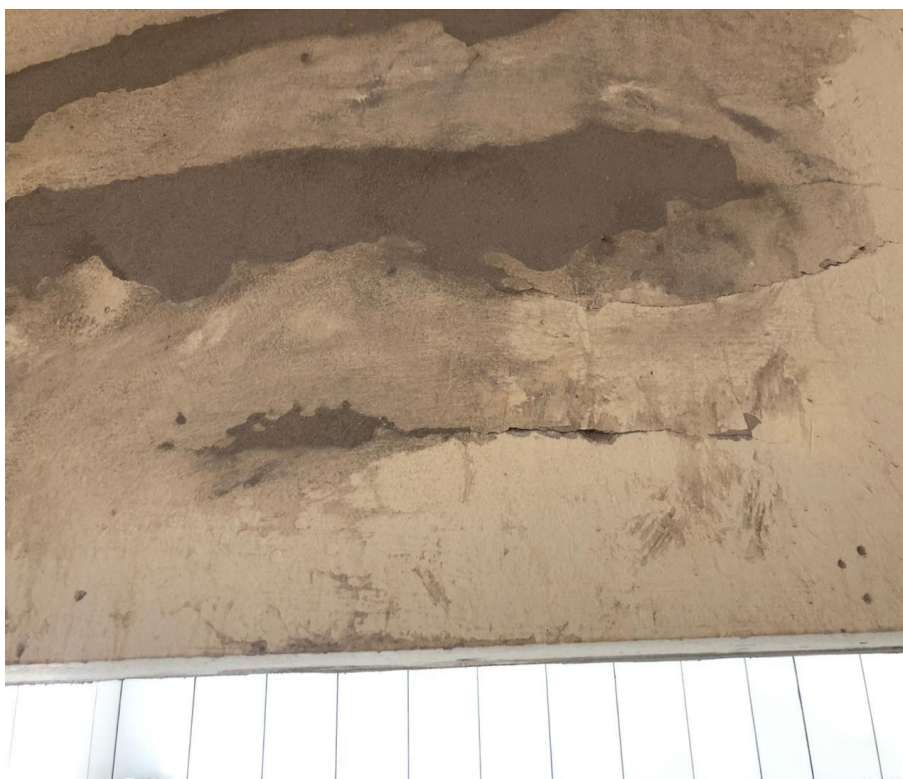
Figura 9 – Aplicação de argamassa na rachadura.
