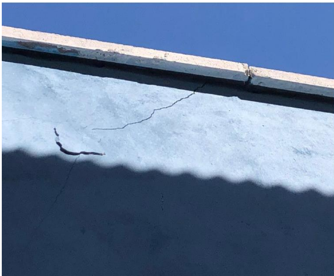
Figura 10 – Retirada da pintura danificada.
