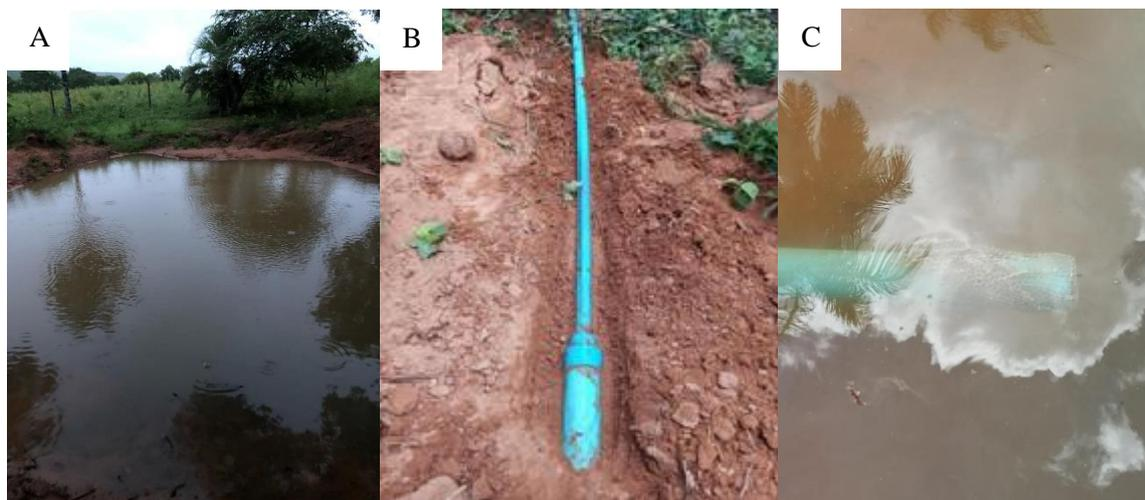
**Figura 6:** Fonte de alimentação do carneiro hidráulico; (A) Barragem artificial para alimentação; (B) Redução da tubulação de 50mm para 25mm de diâmetro; (C) Tela de proteção na entrada da tubulação de 50mm.
