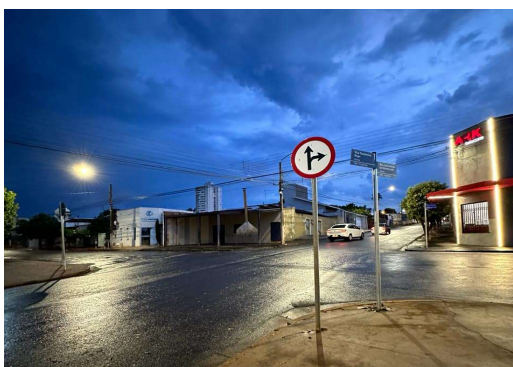
Figura 3: Imagem de interseção sem rampas na travessia da Rua Teodomiro e Rua José Antônio.
