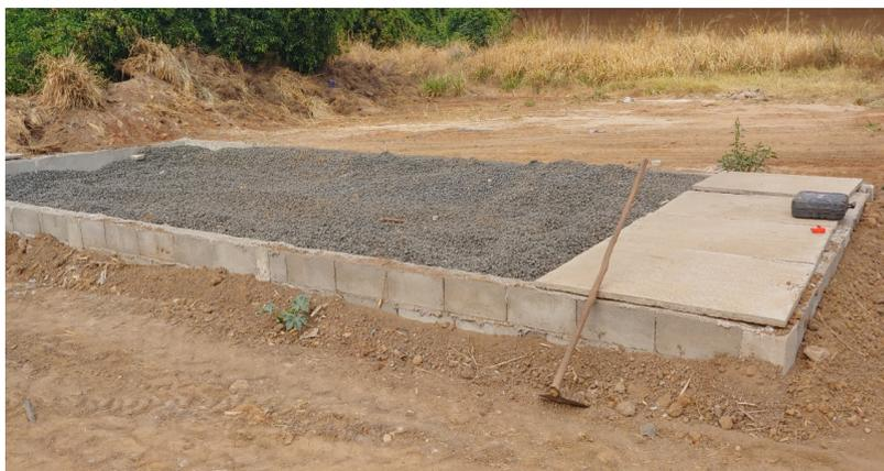
Figura 1. Tanques sépticos e Wetland construída, ainda sem o plantio de mudas.
