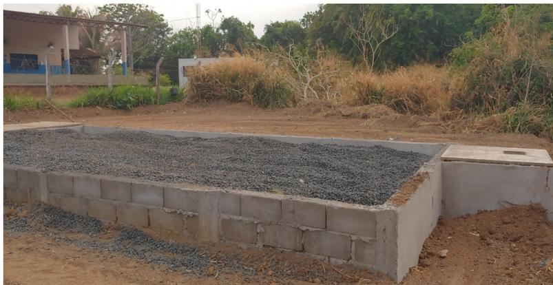
Figura 2. Wetland construída sem o plantio de mudas e tanque de recalque do esgoto tratado.
