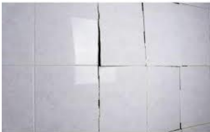
FIGURA 1: Representação do deslocamento em revestimento cerâmico FONTE: QUARTZOLIT (2018)
