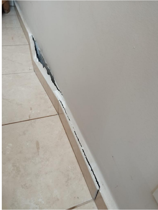
FIGURA 4: Representação de saliência em revestimento cerâmico
