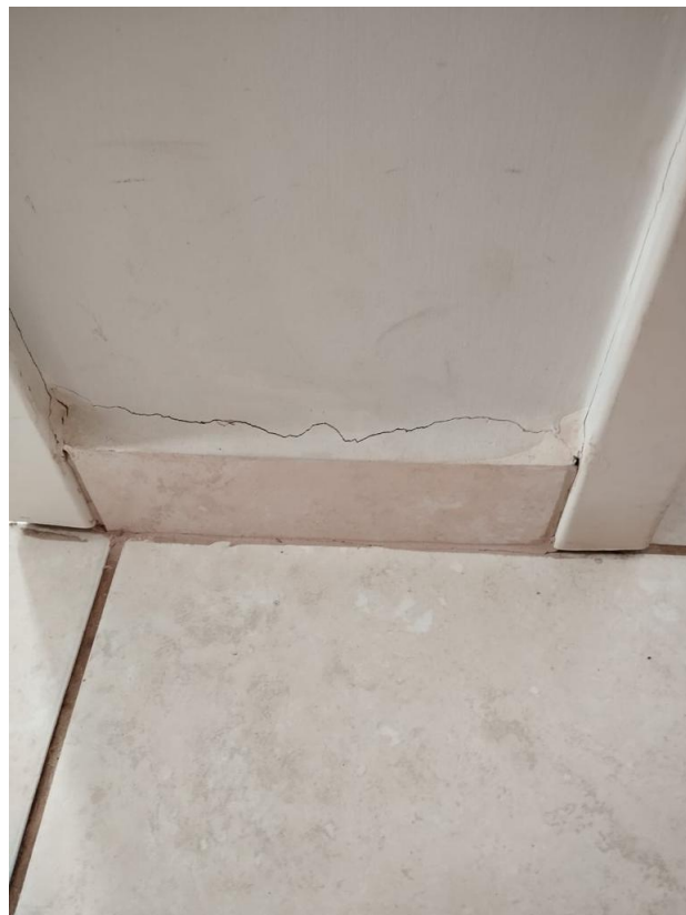
FIGURA 5: Representação de saliência em revestimento cerâmico
