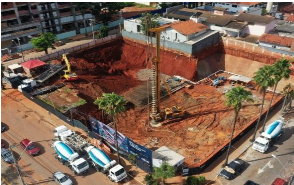
Figura 1 – Execução da HCM. Fonte: Próprio Autor (2021).
