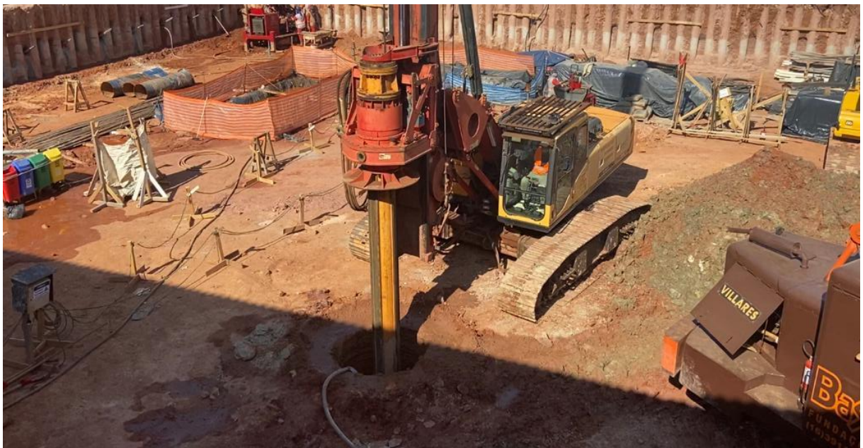
Figura 3 – Execução da EFE. Fonte: Próprio Autor (2022).
