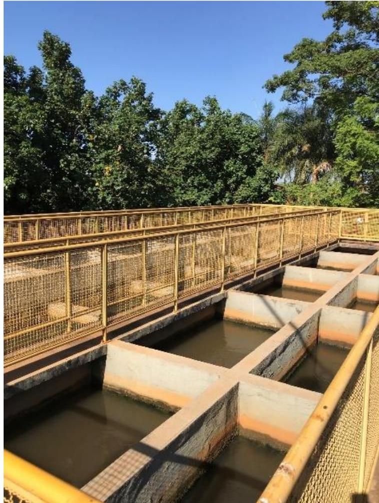
**Figura 5.** Floculador de chicanas em fluxo vertical em funcionamento
