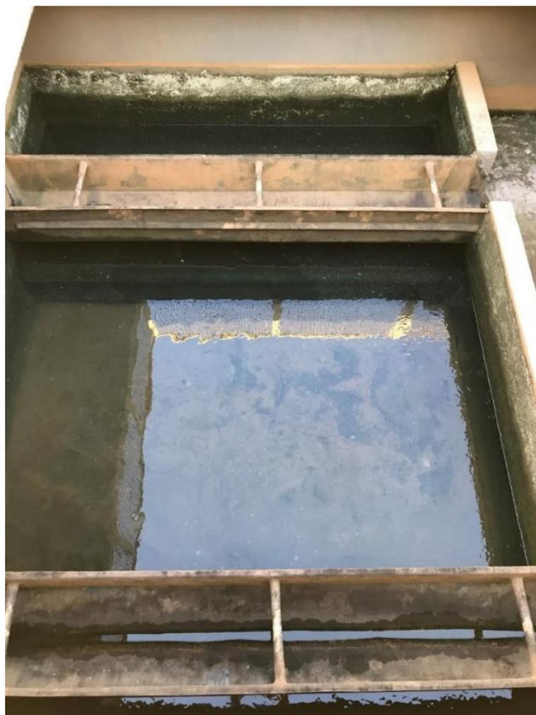
**Figura 7.** Filtro rápido em funcionamento
