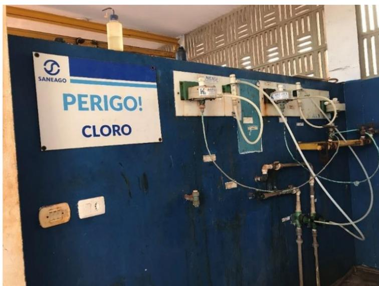
**Figura 10.** Bomba dosadora de cloro
