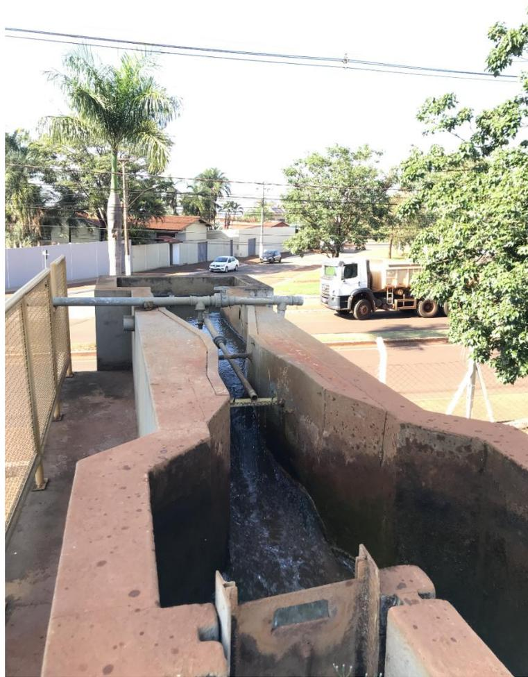
**Figura 2.** Calha Parshall em funcionamento
