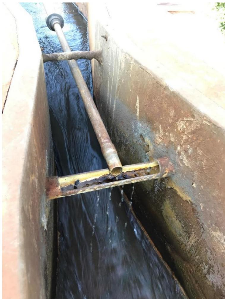
**Figura 1.** Adição do coagulante Sulfato de Alumínio na água bruta
