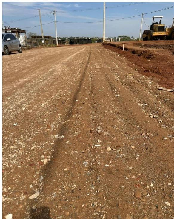
**Figura 3:** BGS misturado com cascalho convencional.
