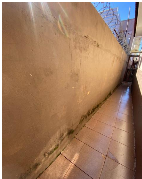
Figura 36: MP 14 - Lavanderia Fonte: Próprio Autor, (2023).
