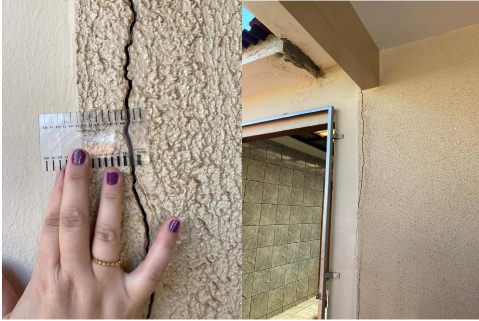
Figura 30: MP 10 – Garagem. Fonte: Próprio Autor, (2023).
