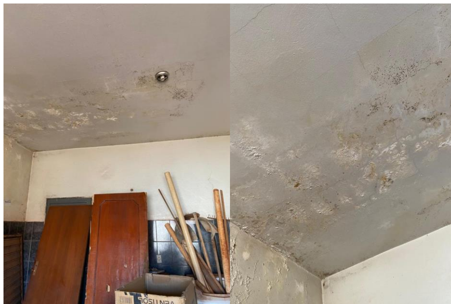
Figura 25: MP 05 - Laje escritório. Fonte: Próprio Autor, (2023).
