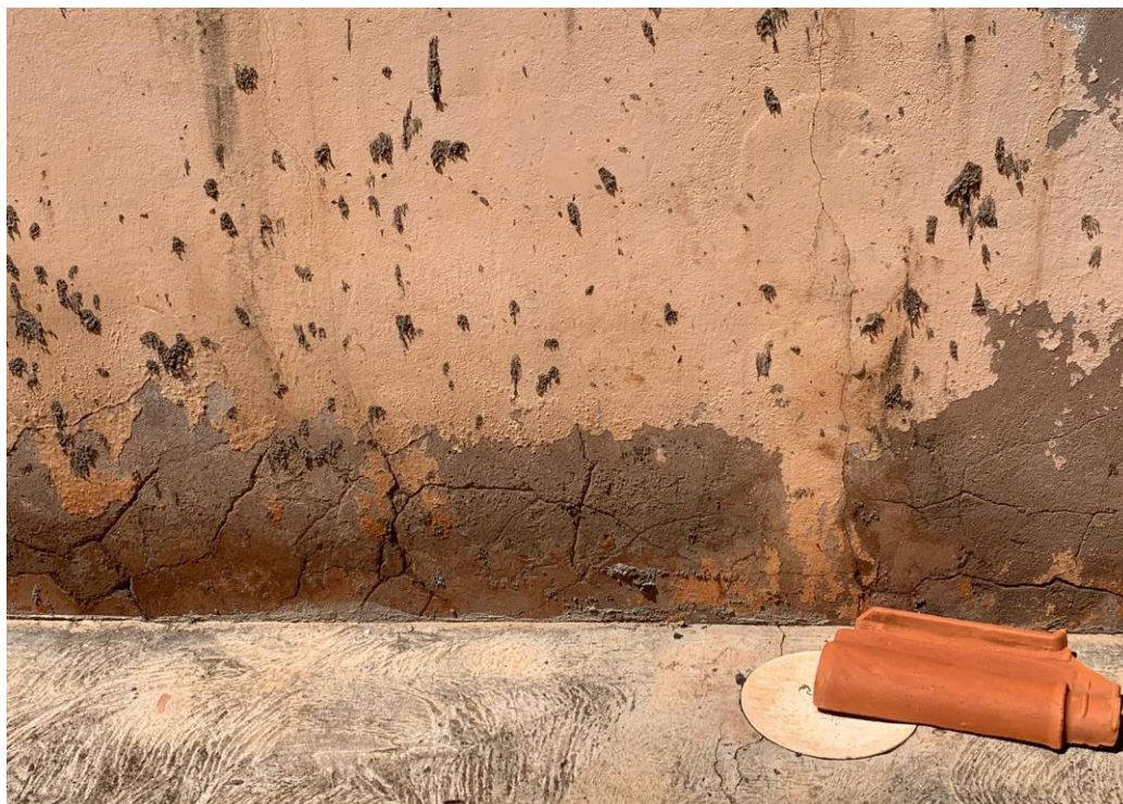
Figura 14 - Parede externa da cozinha
