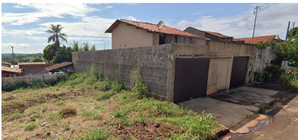
Figura 5 – Residência – Ituiutaba-MG, vista lateral
