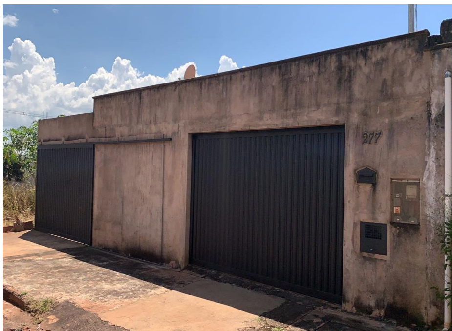
Figura 9 - Fachada da casa
