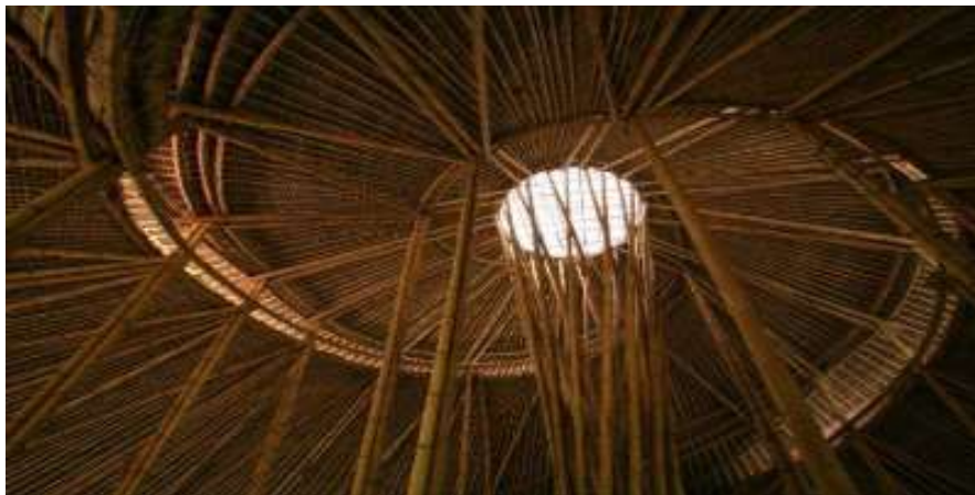
Figura 13. Coluna central de sustentação com claraboia no topo.
