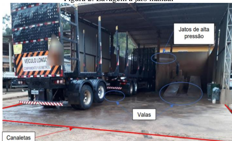
Figura 2: Lavagem a jato manual
