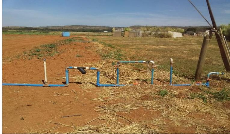
**Figura 3.** Cabeçal de controle contendo torneira, venturímetro, filtro de discos e manômetro.
