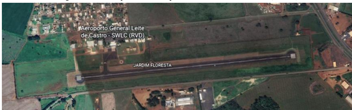
Figura 2 - Vista superior do Aeroporto General Leite de Castro (SWLC)
