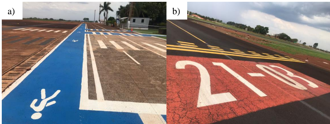
Figura 10 – Indicação a) área de caminhada para passageiros e operadores b) cabeceira e parada na via de acesso a PPD do Aeroporto de Rio Verde
