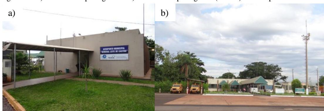
Figura 11 - a) Terminal de passageiros e b) Terminal de passageiros (lado ar) do Aeroporto de Rio Verde
