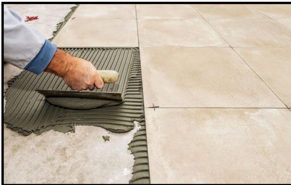
Figura 10- Assentamento de revestimento cerâmico fora do objeto de estudo.
