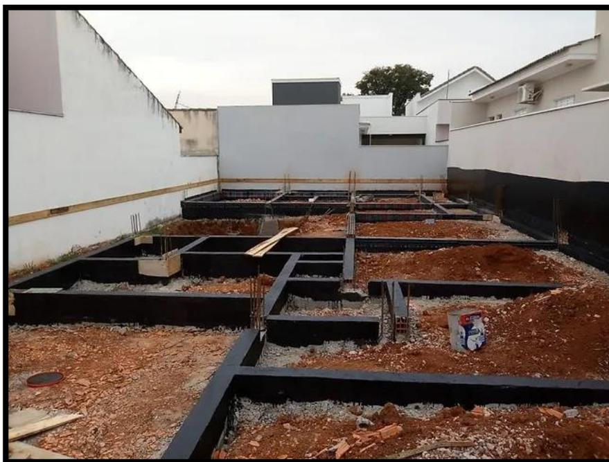
Figura 7- Impermeabilização de vigas baldrame fora do objeto de estudo.
