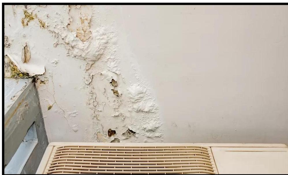
Figura 6- Parede com infiltração fora do objeto de estudo.
