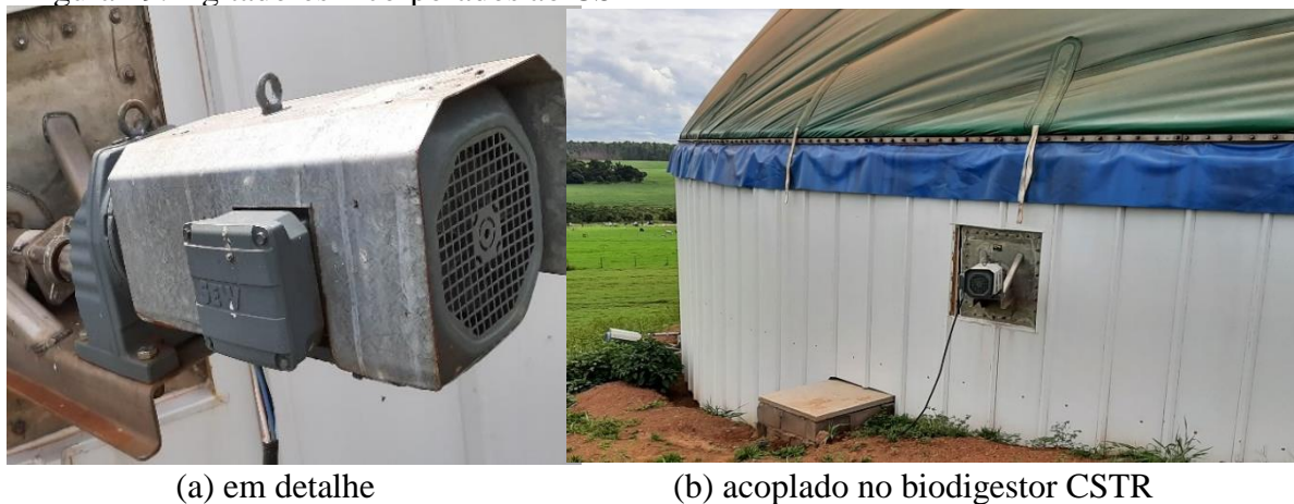
Figura 19. Agitadores incorporados ao CSTR
