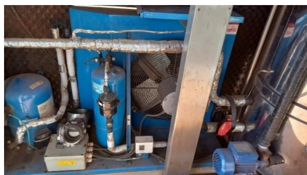
Figura 15. Filtro de secagem por condensação em uso no CSTR
