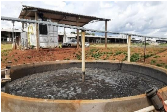
Figura 25. Ponto (I): coleta do dejetos na entrada dos biodigestores
