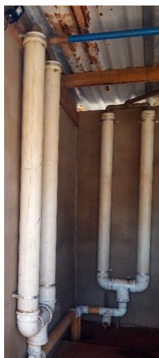
(a) Filtro comumente utilizado junto aos BLC da região para redução de H_2S
